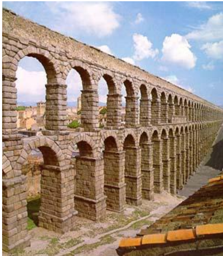
Acueducto romano en Segovia España.
